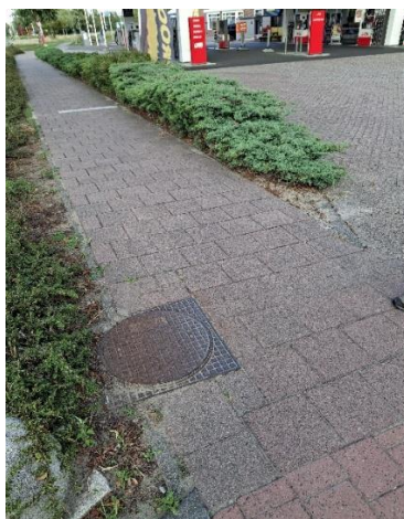
87381 Op de hoek bij de benzinepomp aan de Nassaulaan een putdeksel ligt boven de putrand uit.
